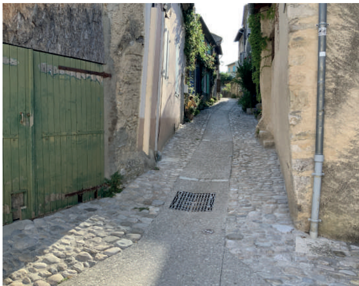
Rue du Châtel : calade galets sur les pieds du bâtiment. Béton désactivé sur une bande centrale de 1.4m pour garantir un confort.
