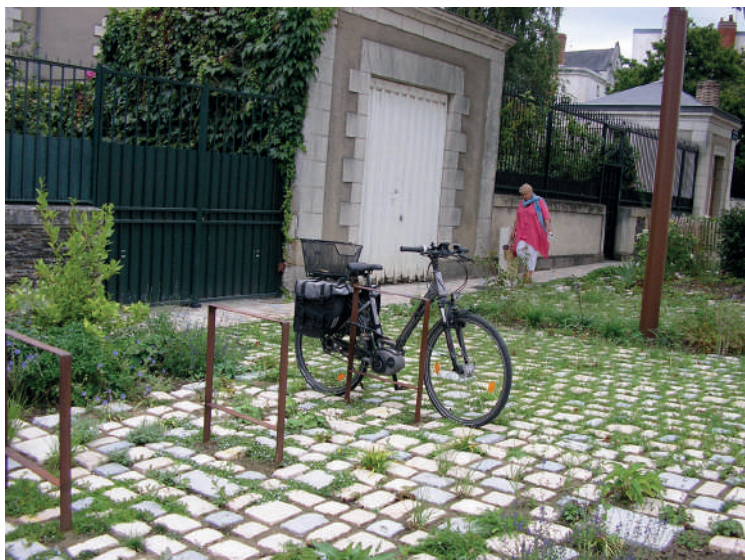
Référence rue jardin - revêtement perméable
