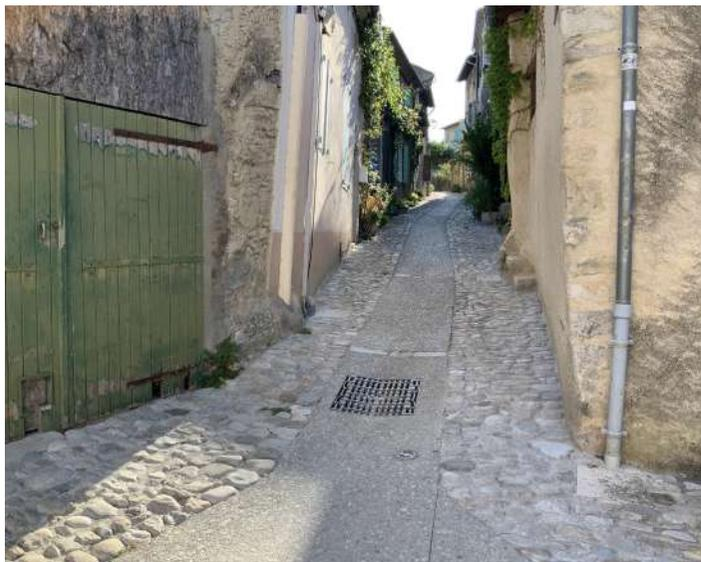
Rue du Chastel : calade galets sur les pieds du bâtiment. Béton désactivé sur une bande centrale de 1.4m pour garantir un confort.
