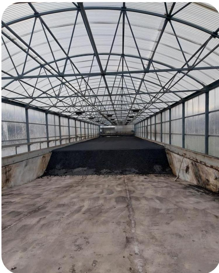
Figure 2 : Serre de stockage des boues après évacuation du stock
