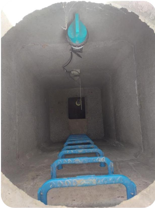
Figure 6 : Localisation de la sonde de mesure après travaux
