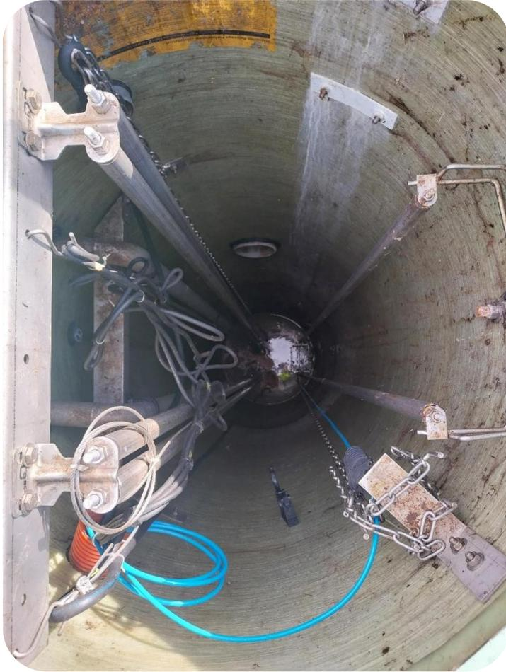
Figure 7 : Poste de relevage de la Géline avec sonde piézométrique
