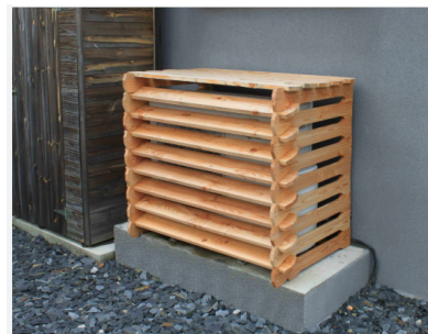
Exemple de traitement pour les échangeurs de climatiseurs.
